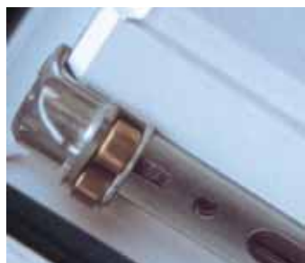
Rolkowy mechanizm naprowadzający skrzydło okna do ramy.
