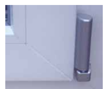
Estetyczne osłonki zawias, nie tylko chronią je przed zabrudzeniem, ale w znacznym stopniu poprawiają wygląd całego okna.
